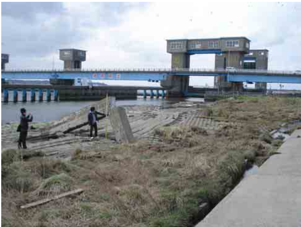
図-13 利根川河口堰下流の被災状況
