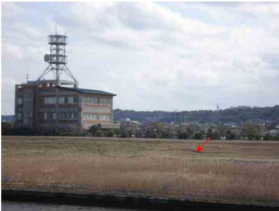
図-15 堤防法面（川表側）の亀裂（矢印箇所）
